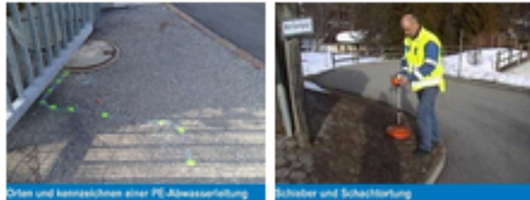
Orten und kennzeichnen einer PE-Abwasserleitung
