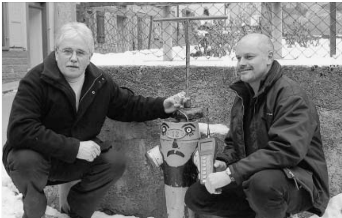
Sender erfassen Leckgeräusche: Georg Stähler und André Willi bei einem Hydranten mit dem Ortomat-System (von links). (Foto Tamara Defilla)
